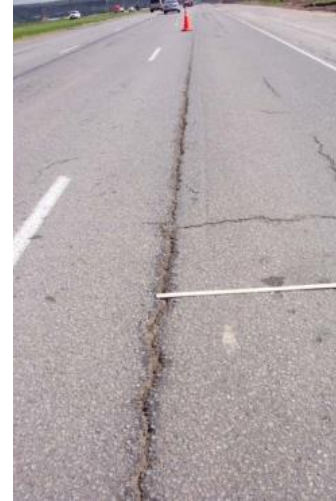
Longitudinal Crack
