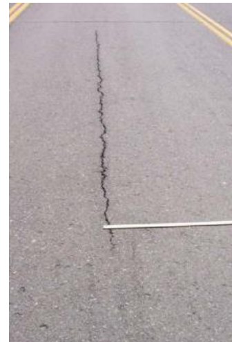
Longitudinal Crack
